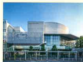
(JR中央線「武蔵小金井駅」南口駅前)
